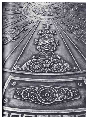
Рис. 10. Мощение дорожки чугунными плитами перед западным входом в собор Покрова Пресвятой Богородицы в Покровском монастыре, Суздаль, Владимирская область Рис. 11. Чугунный пол церкви «Всех скорбящих радость». Москва
